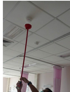
ตรวจสอบ เครื่องตรวจจับควัน
