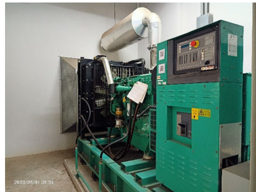
เครื่องกำเนิดไฟฟ้าสำรอง อาคารพักพยาบาล
