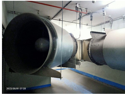
พัดลมระบายอากาศอาคารจอดรถชั้นใต้ดิน
